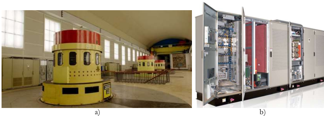
Slika 5.2.2 a) Sinhroni generator b) pobudni sistem u HE „Piva“
